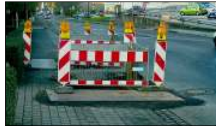
Eine Metallabdeckplatte ist vorbildlich mit Bitumenkeilen gesichert. Die Stahlplatte sollte rutschsicher ausgeführt sein.
