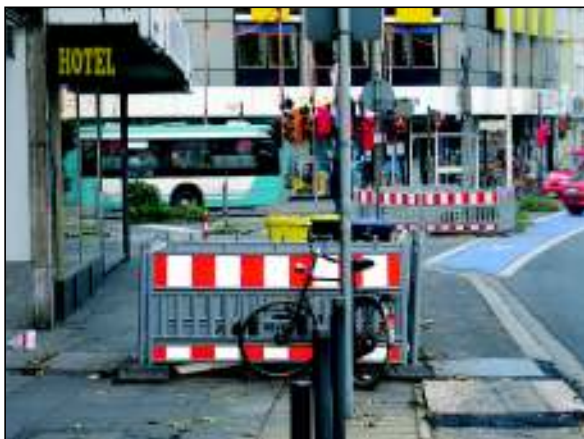
Gut gelöst: Der Radweg ist auf gesamter Breite nutzbar, die Kanten der Abdeckung sind angeschrägt.
